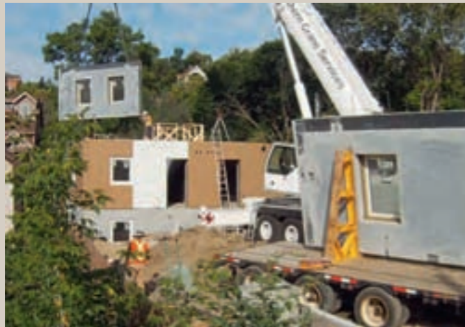
Construction d'une résidence duplex innovante autonome en énergie. L'utilisation de panneaux en béton préfabriqué, produits dans une usine Lafarge voisine, a facilité la construction sur site.
